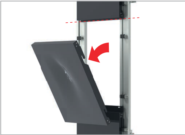
1. Retirada de la bandeja dañada cortando por la pestaña superior.
