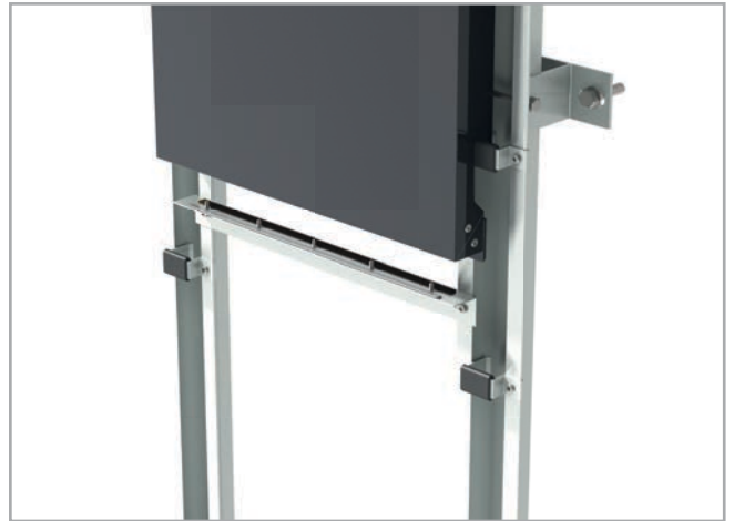
4. Colocación de adhesivo y cinta doble cara específicos en el perfil "L" 30 x 20 mm.
