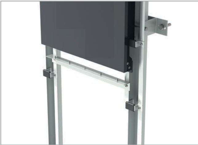
3. Colocación de tornillos 4,2 x 13 DIN 7504 N inox en perfil en "L" de 30 x 20 x 1,3 mm, y fijación de éste al perfil OMEGA.
